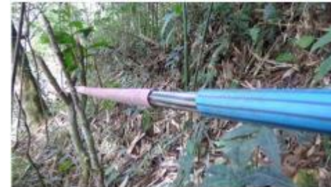
Foto 03: Tendido de agua en mangueras.
